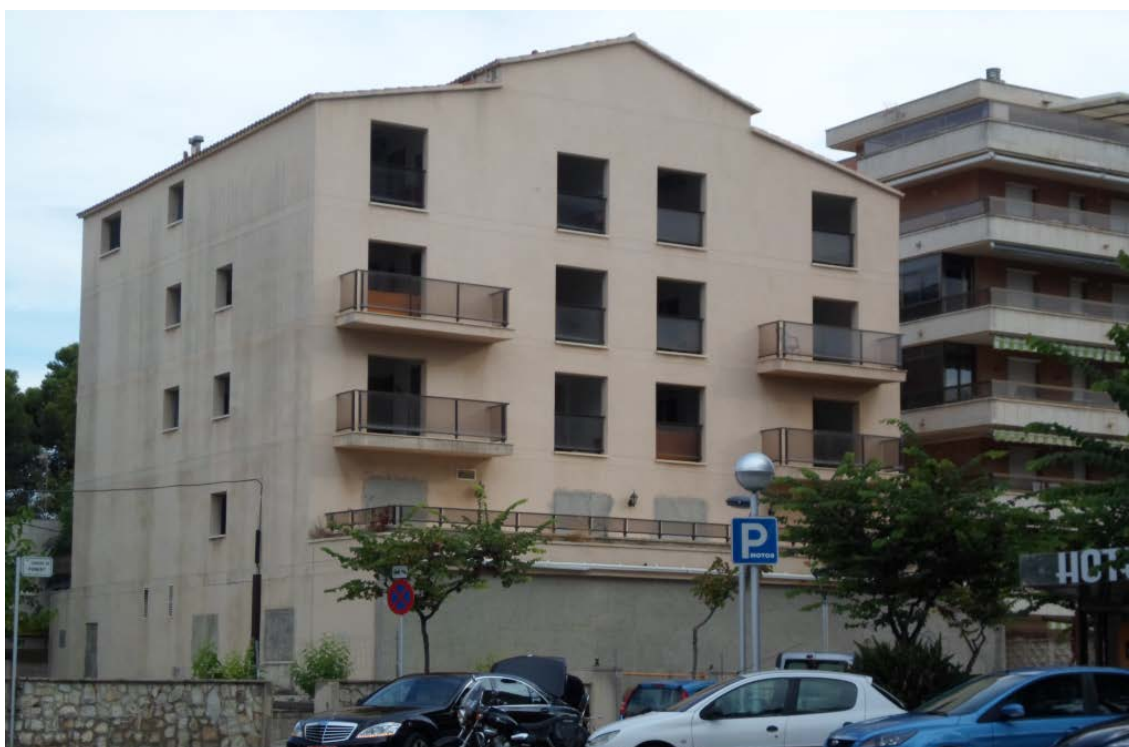
1. Edifici "Jaume I". Estat actual.
